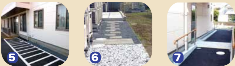
建物の外周のリハビリサーキットでは、坂道や段差、砂利道、横断歩道など、実際近隣に出かけるために必要なトレーニングの環境を整えました。
